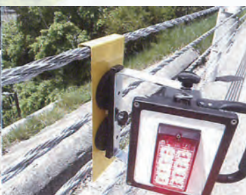
ガードケーブルに設置
