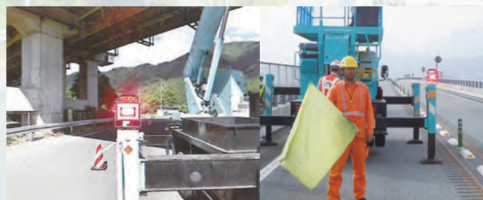
作業車のアウトリガーに設置
